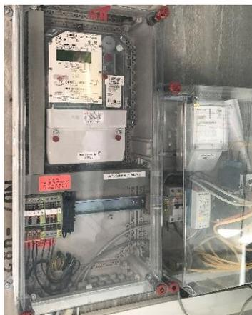
Turmmontage mit 2 Meßkanälen und Netzwerkanbindung
